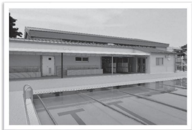
学校施設の整備（写真は学校プール）
