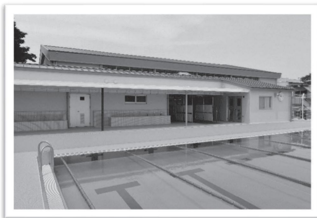
学校施設の整備（写真は学校プール）
