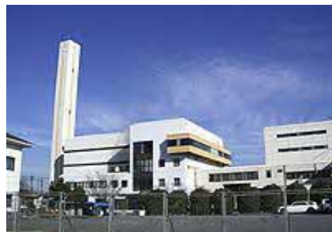
八甫清掃センター ごみ処理施設
