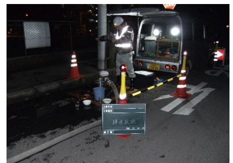
夜間管路洗浄作業の様子
