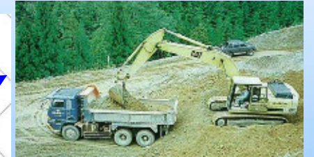
機械寸法： 7.7×2.5×3.3(m) (10tダンプ) 7.3×2.5×9.3(m) (0.45m 3 バックホウ)
