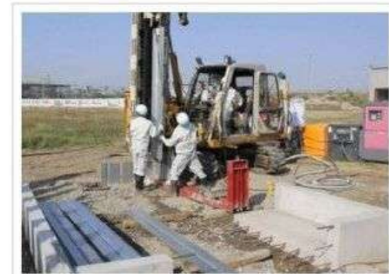
液状化対策工法の実証実験で、地中に鋼板を打ち込む作業員ら＝浦安市舞浜で
