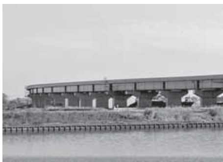
▲建設中の圏央道
