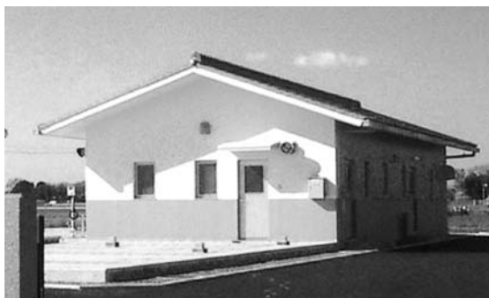
▲農業集落排水処理施設
