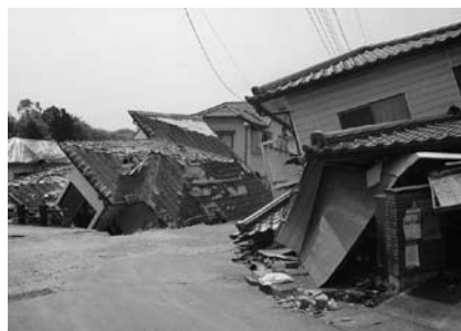
▲平成28年4月の熊本地震における益城町での被害の様子
