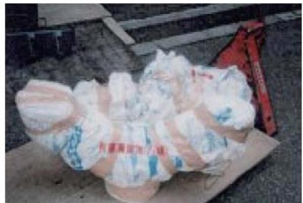
図 4-17 除去した石綿含有保溫材配管を梱包し、廃石綿等として処理した例
