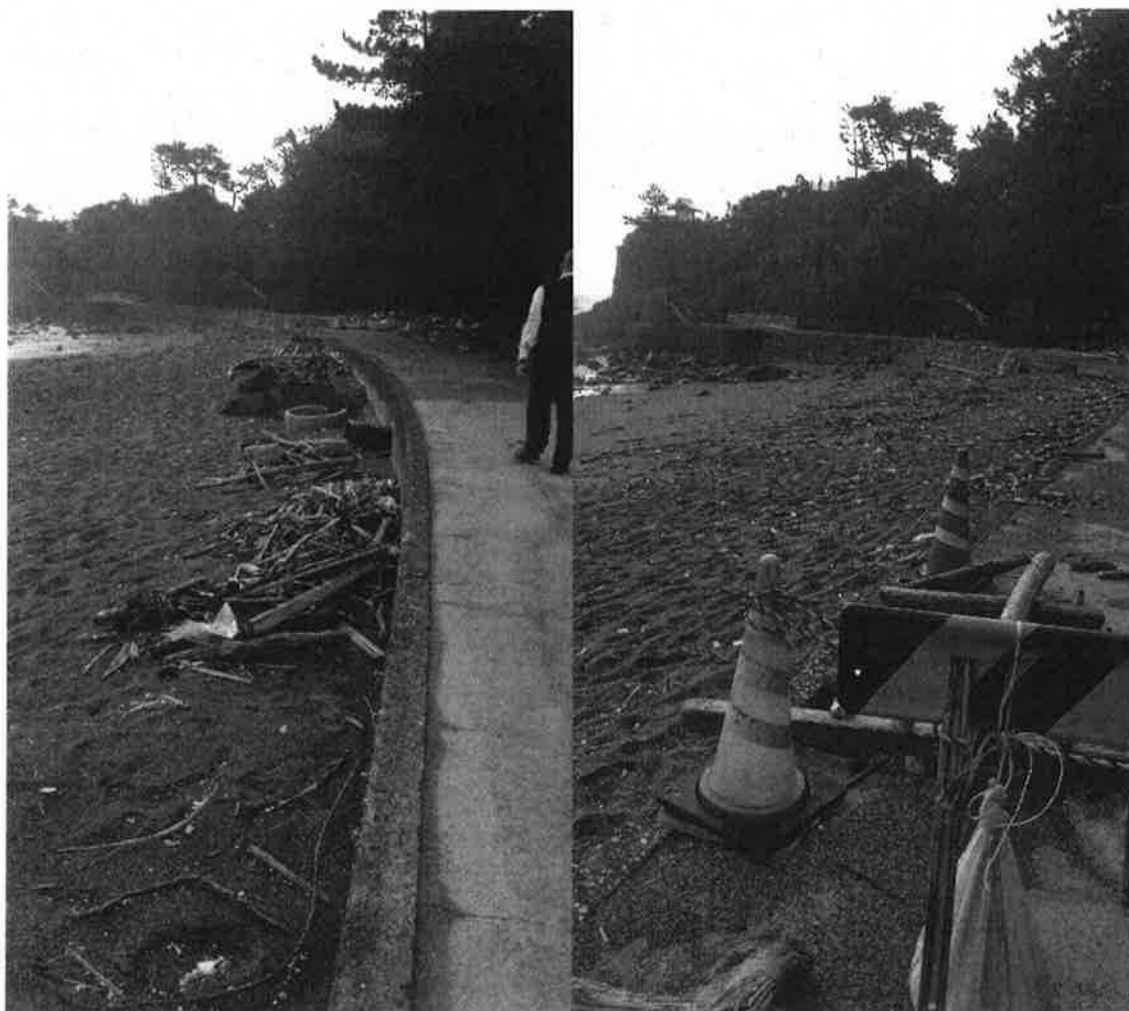
高潮被害による流木
