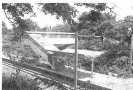
常磐線に向けて工事が進む
