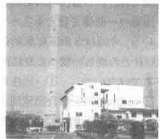
建て替え予定の菖蒲清掃センター
