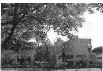
急がれる小中学校雨漏り対策
