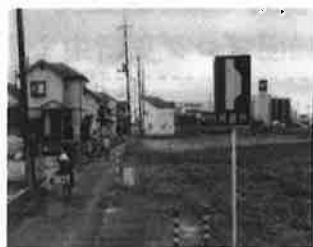
狭くて危険な市道
