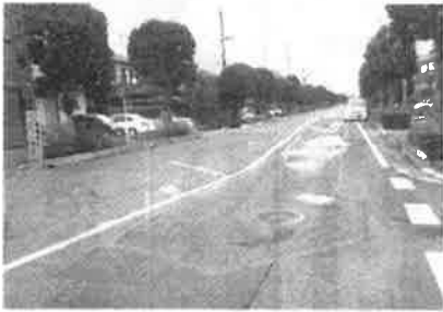
南栗橋 10 丁目付近、対策工事に伴い道路が凸凹、修復を求め、修復中です。
