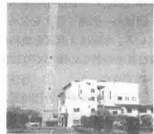
建て替え予定の菖蒲清掃センター
