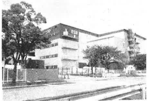
< I-Shop Road 現在建設中 >
