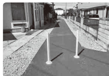
南4丁目地区の水路敷き
