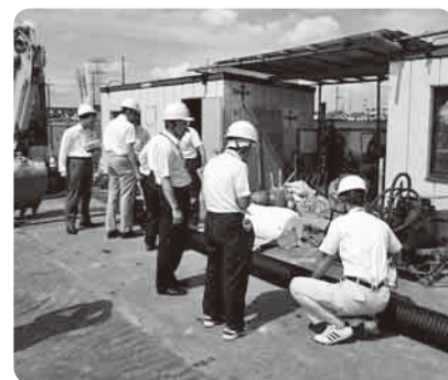
埋設する排水管の説明を受ける委員
