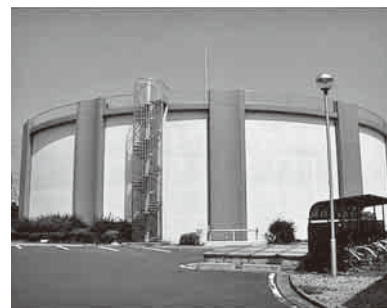
地下水を汲み上げている吉羽浄水場
