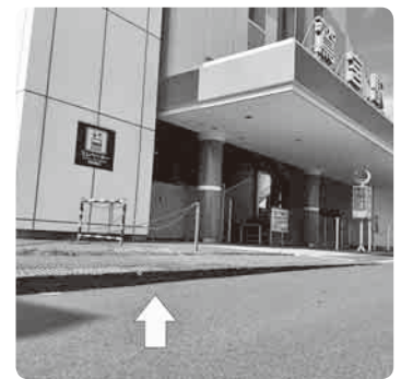
東武鷲宮駅東口の段差
