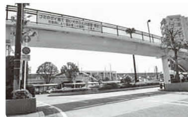
再整備が求められる久喜駅西口ロータリー
