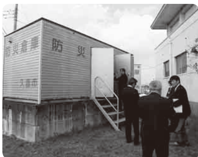
浸水対策で地面から1mかさ上げされている防災倉庫（久喜総合運動公園内）
