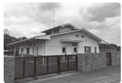
集落排水施設
