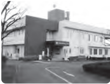
建設部門の拠点の第2庁舎
