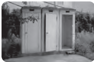
これが鷺宮運動広場のトイレ
