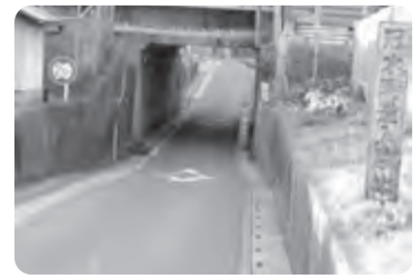
道路冠水の危険性のあるアンダーパス
