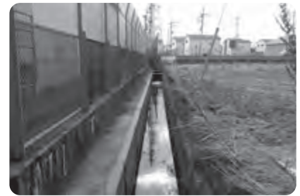
東電変電所裏の西大輪下排水路
