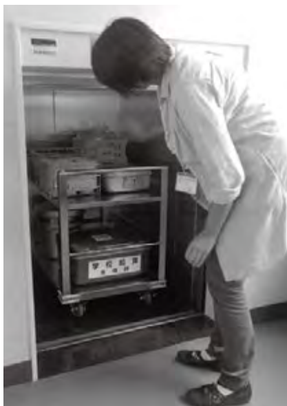
桜田小学校の給食用エレベーター
