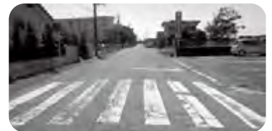
今年度に補修工事予定の市道鷲宮8号線
