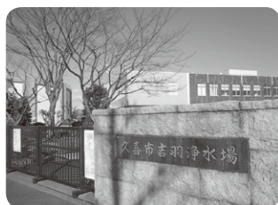
久喜市民へ水道水を供給する久喜市吉羽浄水場
