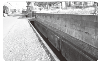
下清久市道久喜217号線の側溝の蓋掛けを
