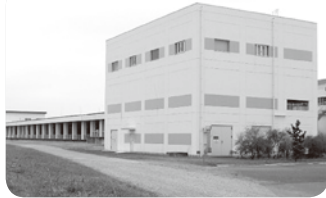
下水処理場周辺の悪臭の苦情に対応を
