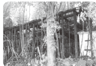
空き家の納屋部分が火災で焼失した(青毛地内)
