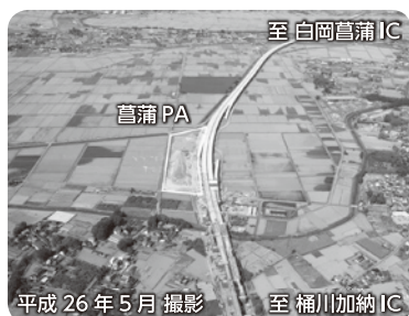
菖蒲PAにスマートインターチェンジの設置を求める (国土交通省 大宮国道事務所 HP より)
