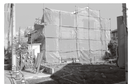
復旧を進める南栗橋の被災地域
