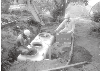
合併処理浄化槽の設置工事
