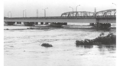
国道4号利根川橋
