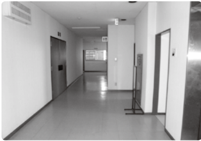
鷲宮総合支所5階のフロア
