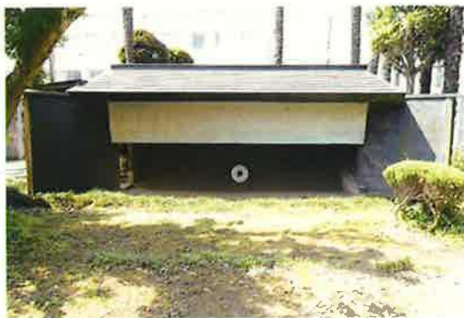
的場の外観（北北東より）
