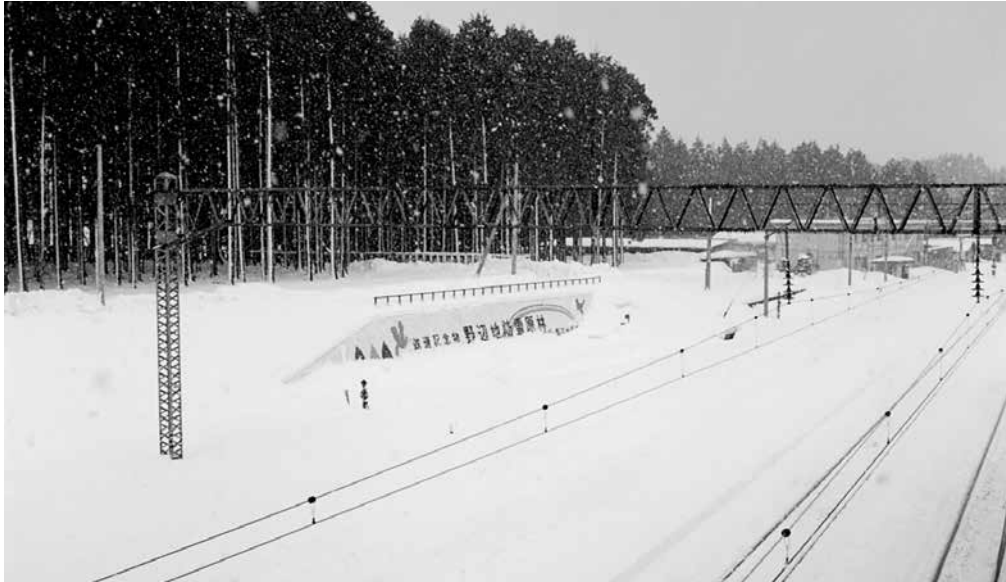
100年以上にわたり、野辺地駅を地吹雪から守ってきた防雪原林。幅400m、奥行きは約60m、約1,250本の杉が林立している。
