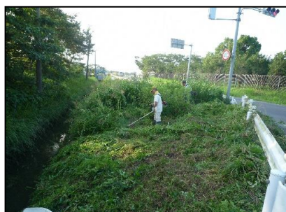
( 農道法面の草刈り )
