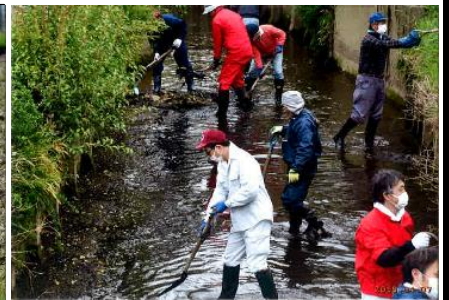
( 排水路の浚渫 )
