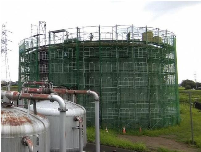
八甫浄水場 PC タンク(耐震補強工事中)
