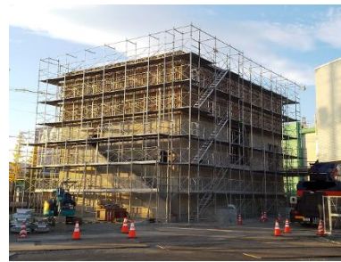
建築中のポンプ棟
