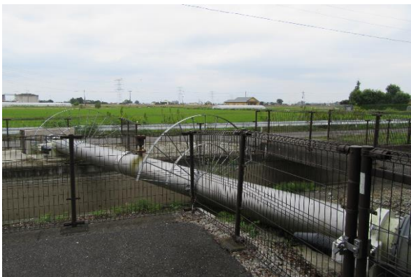
河川や用水路などを横断する水道管です。
