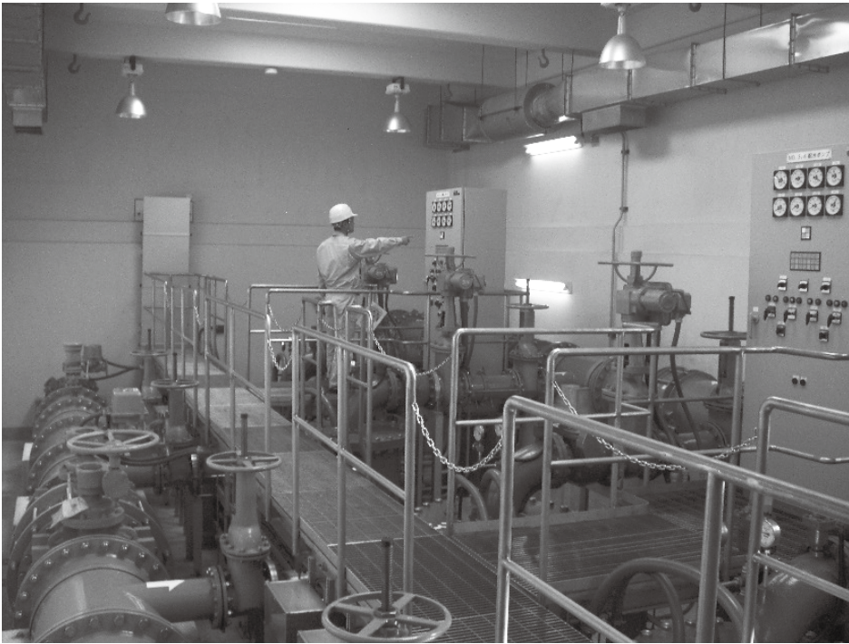
浄水場ポンプ室で設備の被害状況を調査
