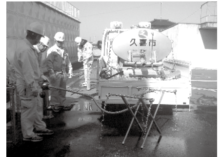
応急給水装置に緊急用給水装置を接続
