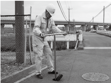
漏水箇所を止水するバルブ操作
