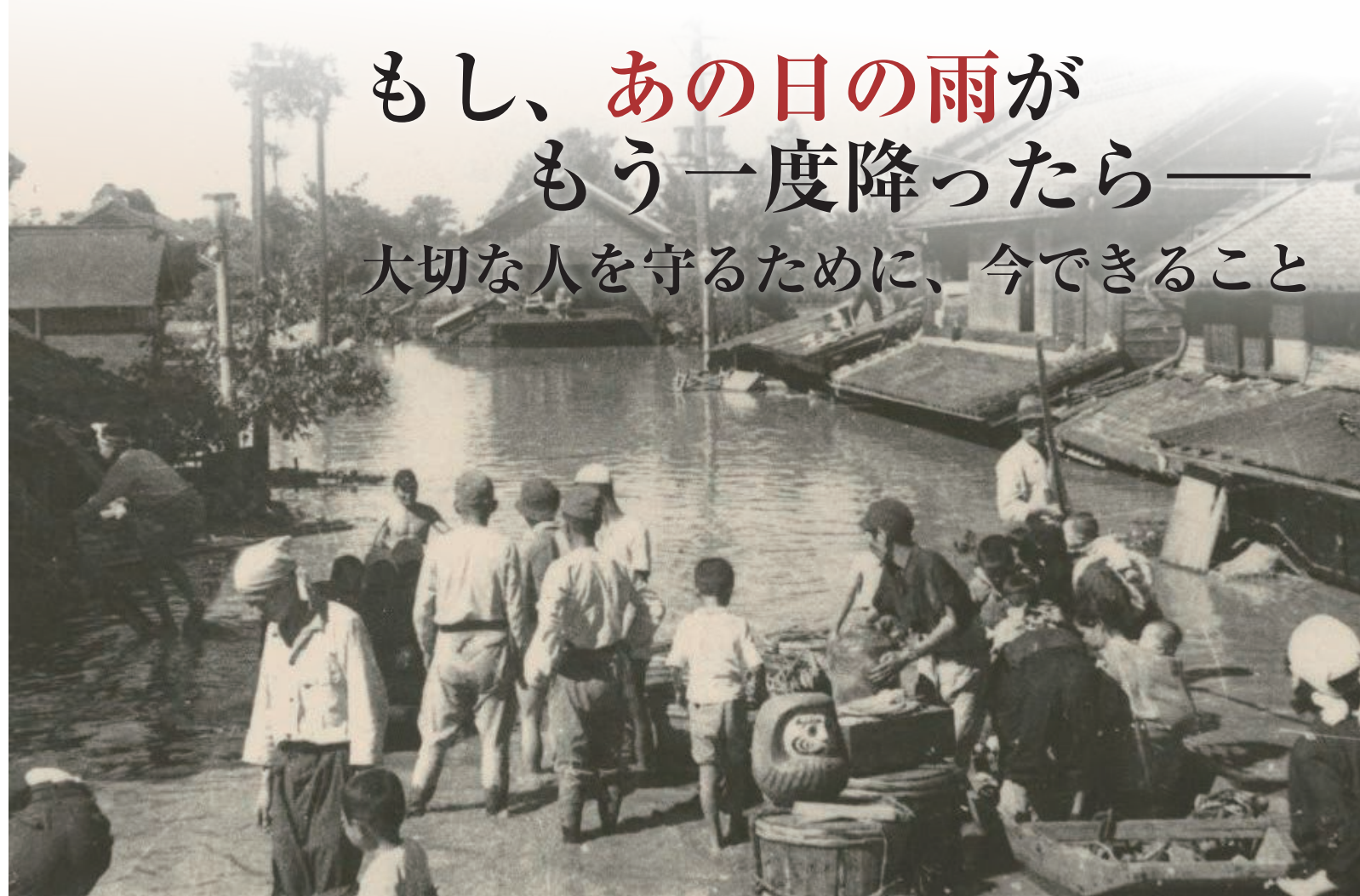
▲昭和22年9月のカスリーン台風で浸水した旧栗橋町の様子（写真出典：利根川上流河川事務所）
