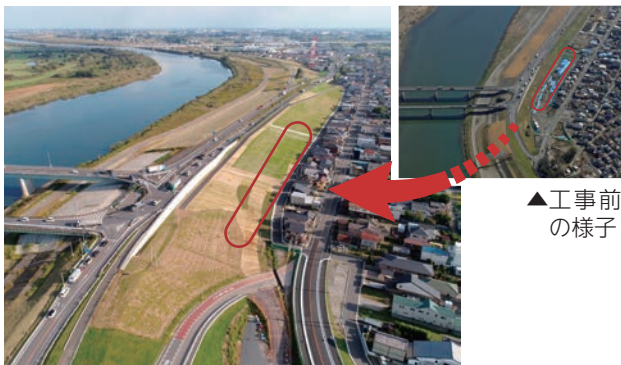
▲工事後の栗橋地区の利根川堤防（写真出典：利根川上流河川事務所）
