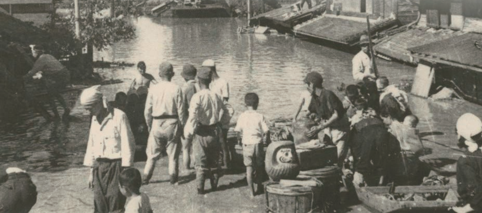
▲昭和22年9月のカスリーン台風で浸水した旧栗橋町の様子（写真出典：利根川上流河川事務所）
