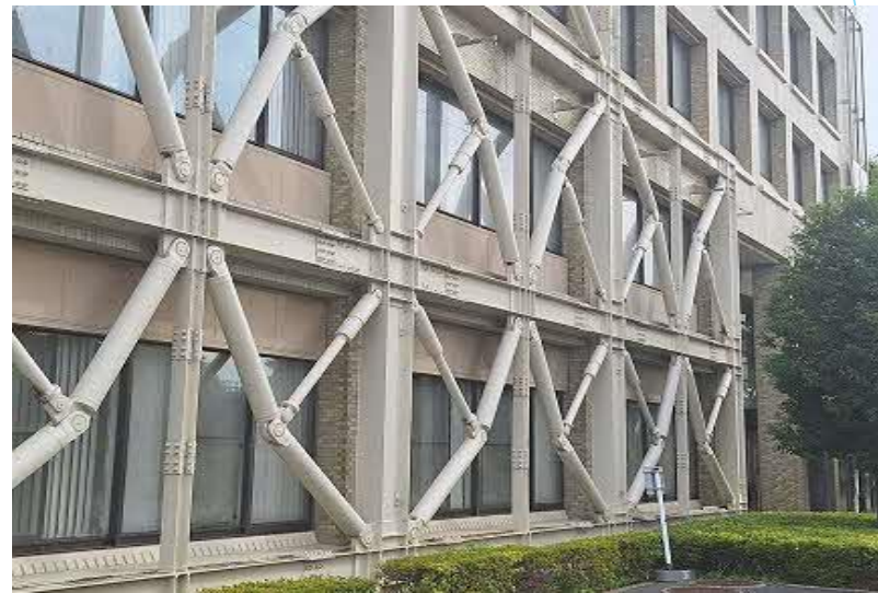
地震の揺れを抑える油圧ダンパー
