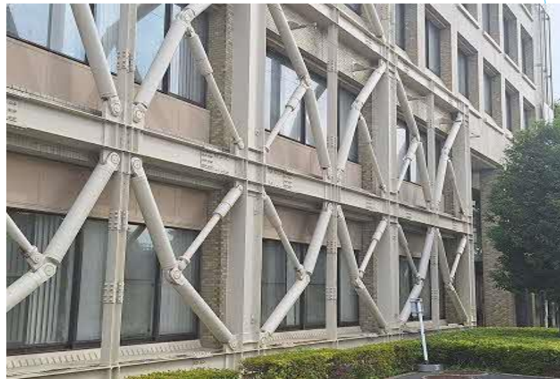
地震の揺れを抑える油圧ダンパー
