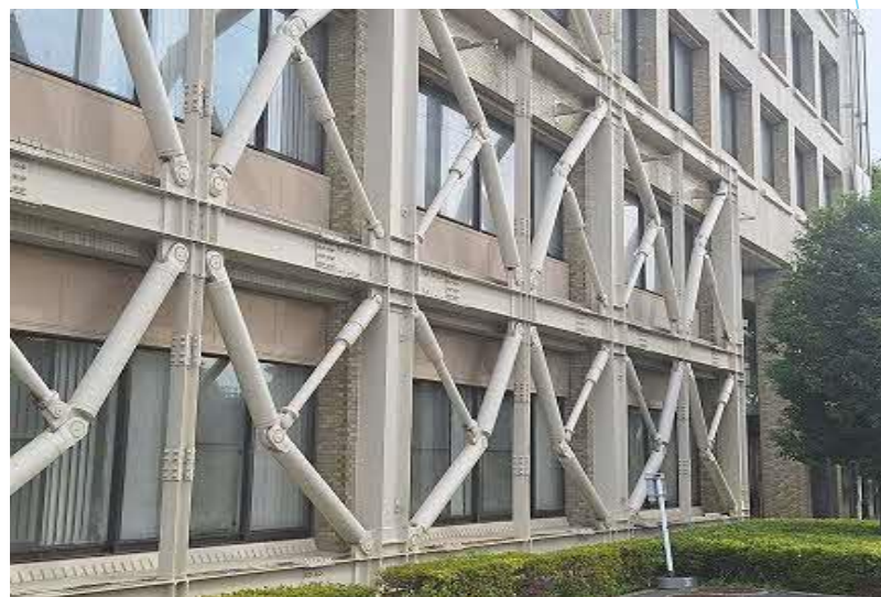
地震の揺れを抑える油圧ダンパー
