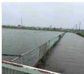
栗橋第2雨水幹線から水が溢れる様子
