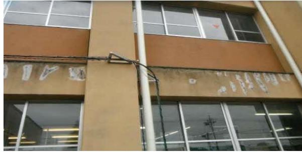
外壁の損傷
