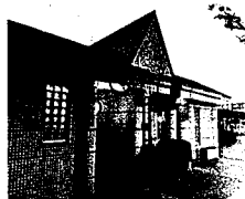
久喜駅：西口の公衆トイレ
