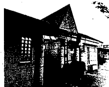
久喜駅：西口の公衆トイレ
