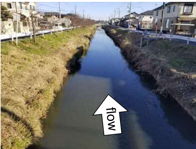
一級河川 青毛堀川 （新道橋下流より）
