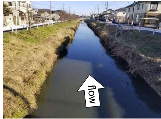
一級河川 青毛堀川 (新道橋下流より)
