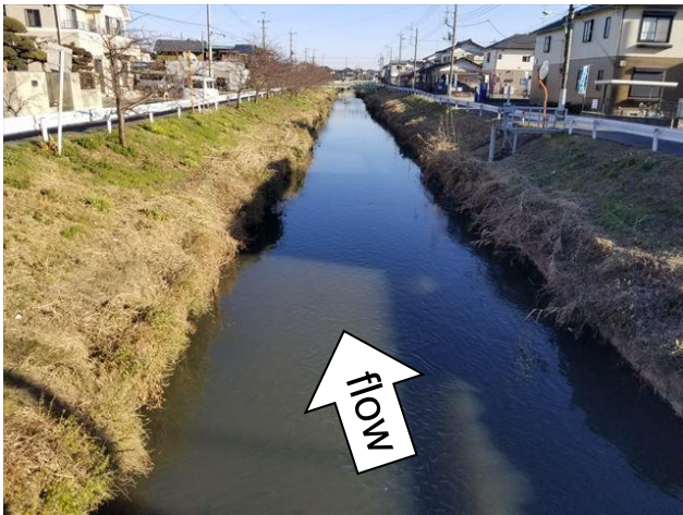
一級河川 青毛堀川 （新道橋下流より）
