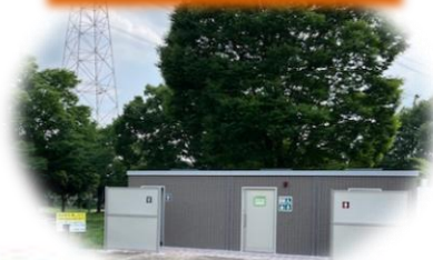
トイレの改修
