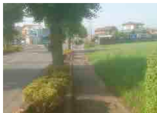
街路樹が根上がりしている市役所通りの歩道
