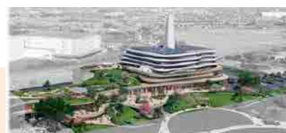
特別高圧電線が布設される新ごみ処理施設
