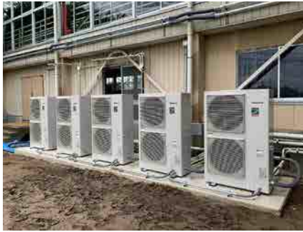
設置工事中の体育館エアコン
