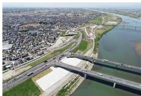
利根川堤防付近の航空写真
