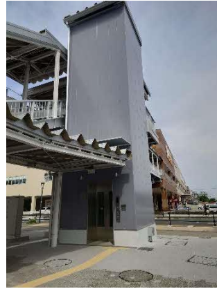
エレベーター
