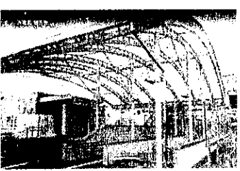
大屋根と駅舎の隙間から雨が吹き込む
