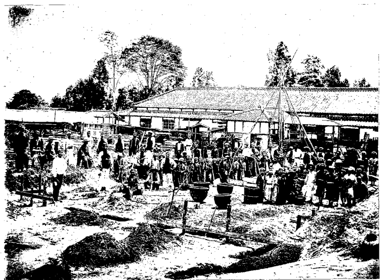
久喜高等小学校の校舎増築（久喜市・明治29年）
