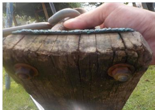
ブランコ 座面の腐朽
