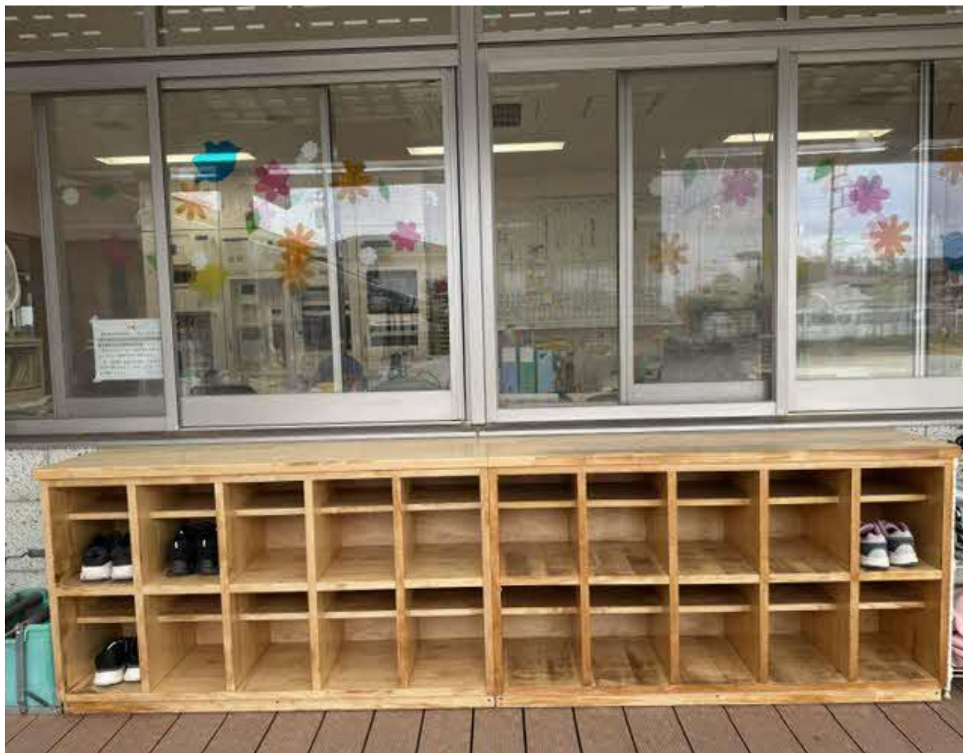
保育園下駄箱改修
