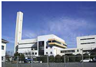
八甫 清掃センター
