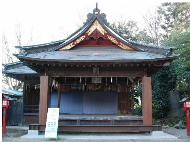
国指定重要無形民俗文化財「鷺宮催馬楽神楽」舞台 神楽殿耐震補強改修工事（Ⅰ期工事） 補助事業
