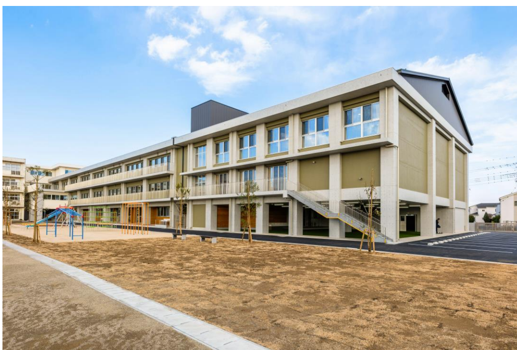
新校舎の外観写真 (鷺宮西小中学校)
